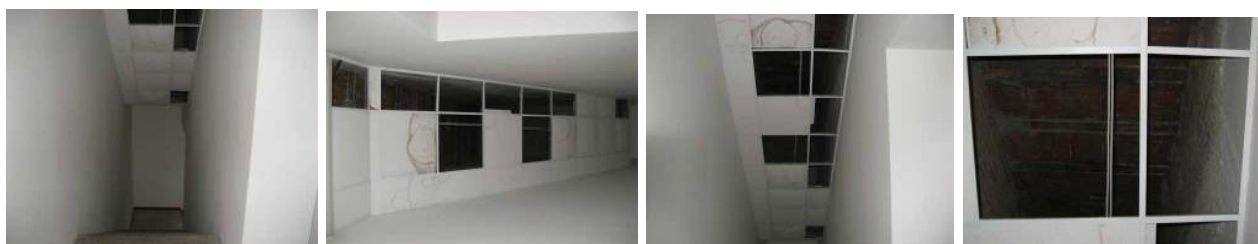
Scalinata alla destra dell'ingresso
